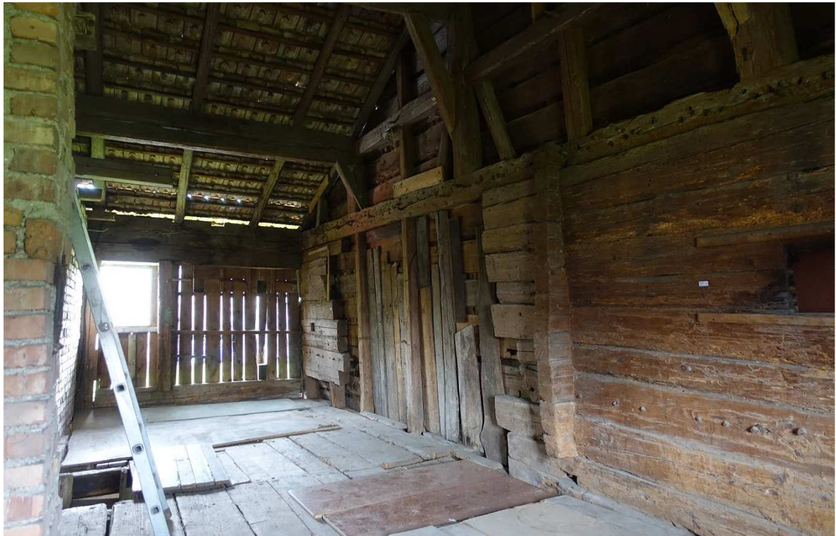
Abb. 19: Erhaltene Blockwand der westlichen Giebelseite.
