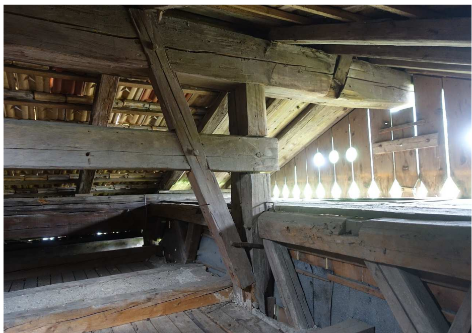
Abb. 28: Veränderte Firstausbildung am Ostgiebel: der Firstriegel ist gekappt und das Kopfband nach Osten entfernt worden; unten ist das einfache Bundwerk zu sehen.
