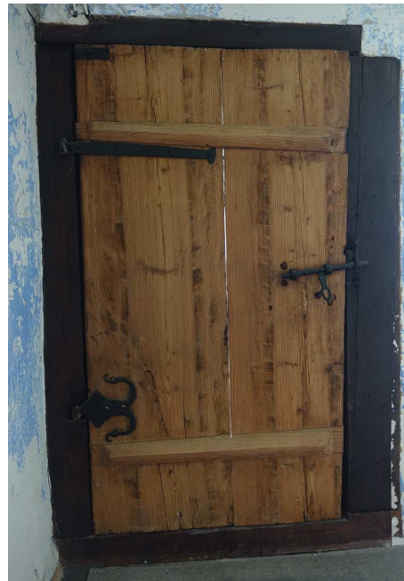
Abb. 8: Bohlentür mit Gratleisten.
