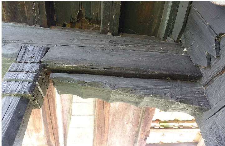
Abb. 12: , Konsole mit schälchenförmigem Profil und seitlichen Anfasungen an der Südostecke.
