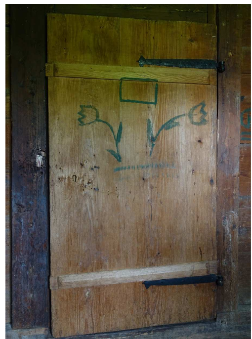
Abb. 18: Brttertür mit Gratleisten und Langbändern; li. Spuren des fehlenden Schlosses.
