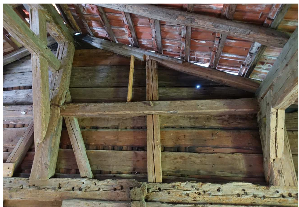
Abb. 23: Oberster durchgehender Blockbalken der Westwand mit zahlreichen Holznagel-Löchern; darüber Dachwerk-Binder des Westgiebels.
