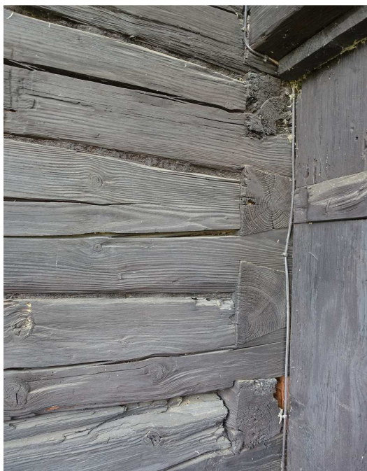
Abb. 14: Konischer Schrot an der Nordostecke, oben die Konsole bündig gekappt.
