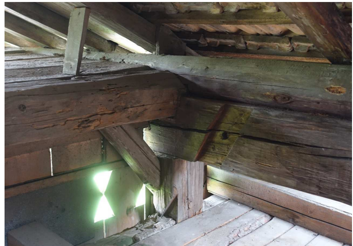
Abb. 27: Ständer unter der südlichen Mittelpfette im Binder am Ostgiebel: beide Längs-Kopfbänder entfernt (vgl. Abb. 13).
