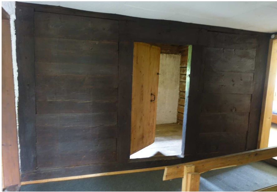
Abb. 16: Bohlen-Ständerwand der Kammer im nördl. Teil des Querflurs.
