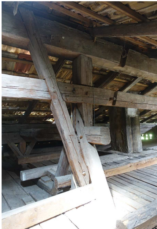
Abb. 27: Ständer unter der südlichen Mittelpfette im Binder am Ostgiebel: beide Längs-Kopfbänder entfernt (vgl. Abb. 13).
