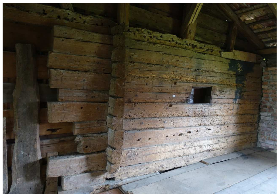
Abb. 20: Nödlicher Teil der Blockwand-West mit gekappter Kegelwand; li. die unregelmäßig endenden Blockbalken.
