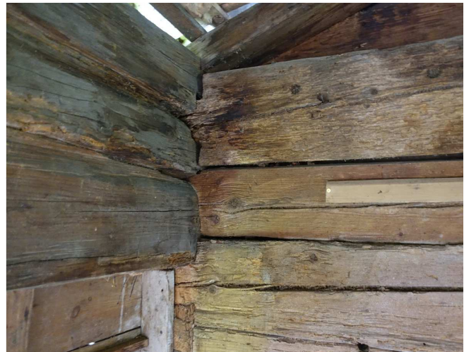
Abb. 22: Die drei obersten Balken laufen an der südlichen Traufwand durch und sind in die westliche Blockwand eingebunden.
