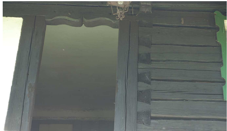
Abb. 6: Zugang zur ehemaligen Laube: Sturz mit ‚Eselsrücken‘, rechts davon ‚Glockenschrot‘.
