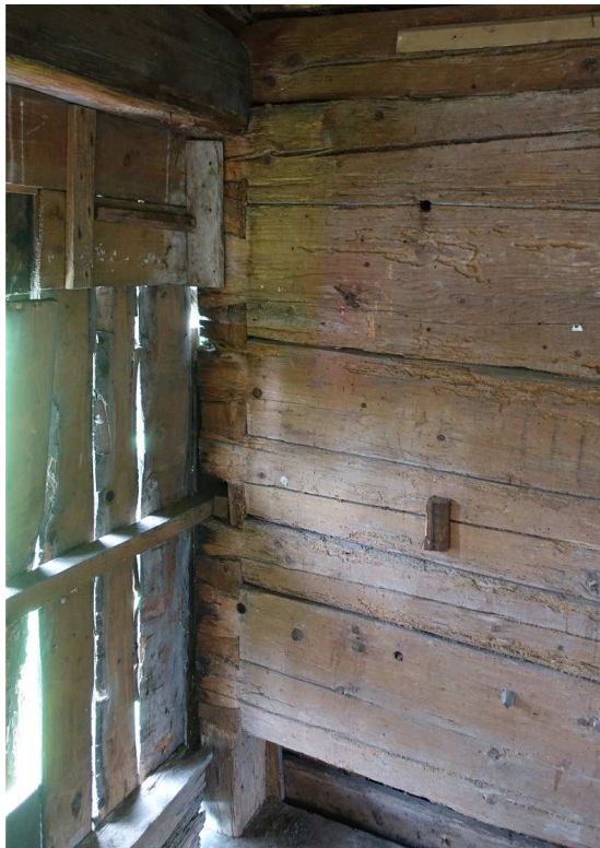
Abb. 22: Die drei obersten Balken laufen an der südlichen Traufwand durch und sind in die westliche Blockwand eingebunden.
