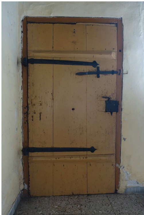
Abb. 3: Bohlentür mit dachförmigen Gratleisten.
