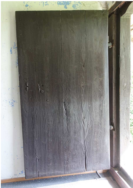
Abb. 7: Türblatt außen mit ‚eingedrückten Streifen‘.
