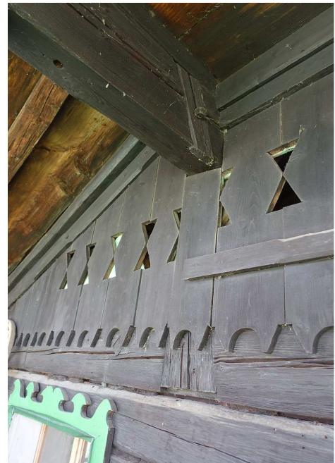
Abb. 13: Auskragung der doppelten Mittelpfette-Süd mit gekapptem Kopfband nach Osten.
