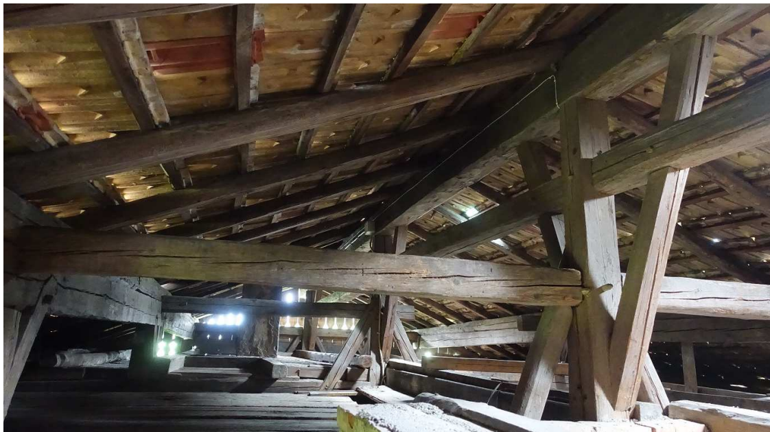
Abb. 24: Dachwerk mit den beiden Bindern über den Flurwänden; Blick nach Osten.
