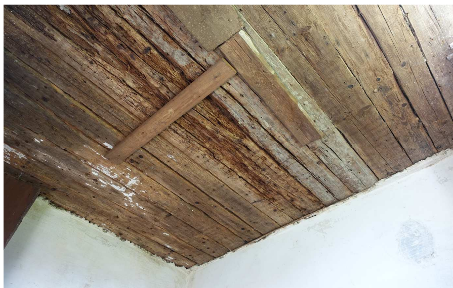
Abb. 31: ‚Mann-an-Mann‘- Decke über dem vertieften Raum; Blick nach Süd- westen.
