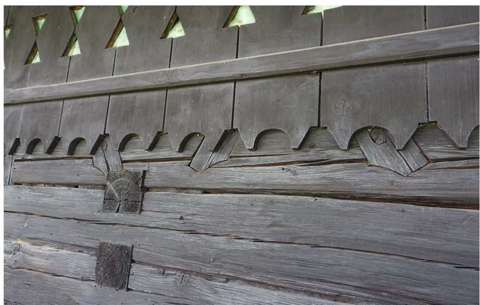
Abb. 11: Untere Verblattungen des Bundwerks am Dreieckgiebel-Ost.
